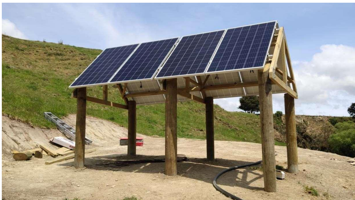
2台用リアクトポンプ稼働用8枚のソーラーパネル
