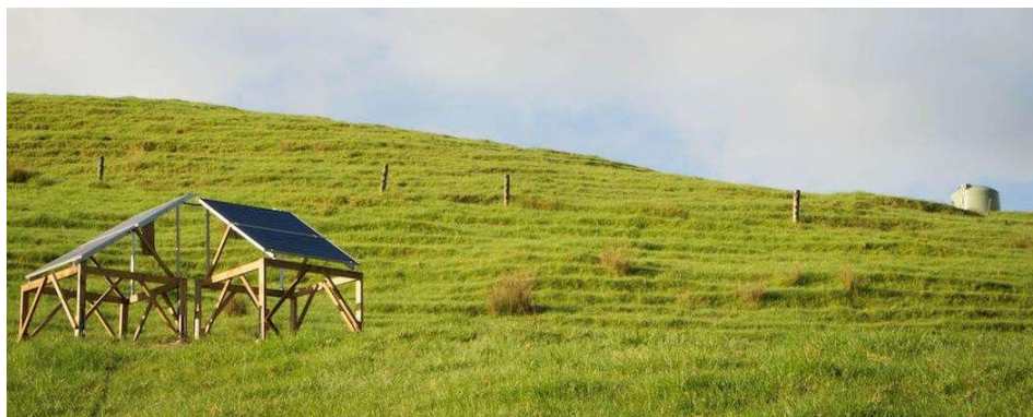
移動可能なフレームで1080WのPV（1フレームあたり540W）
