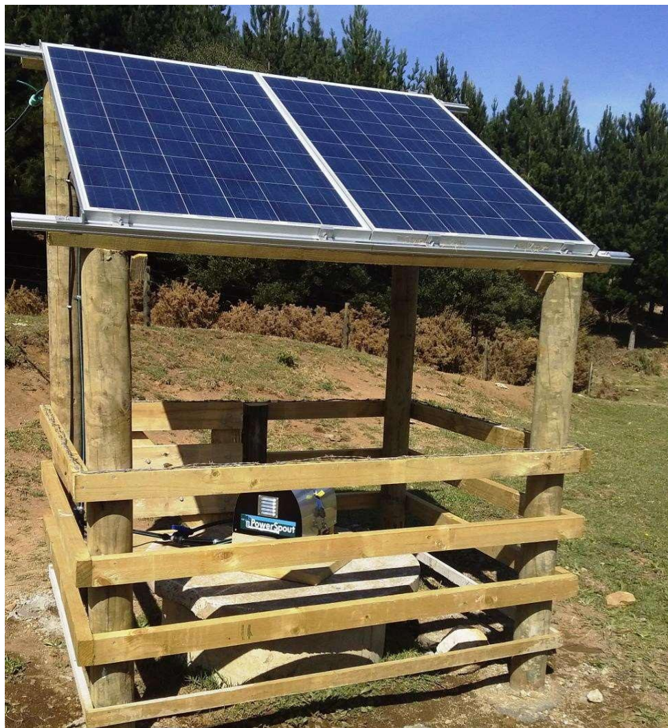
2パネル、平地に近い農場井戸の上に取り付けられたリアクトポンプ
