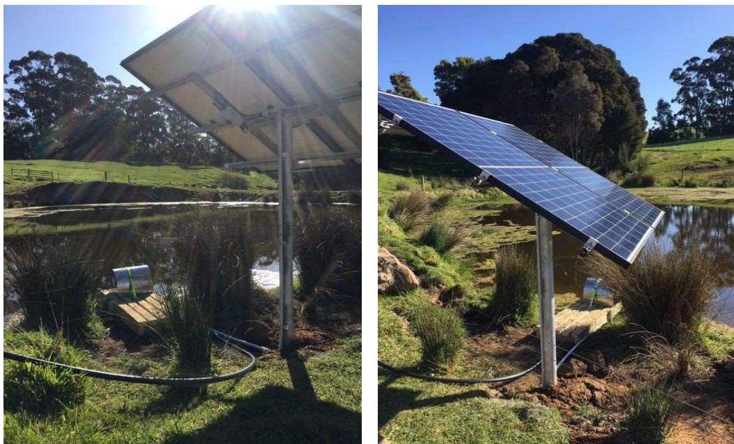
4パネル、農場の池に隣接して取り付けられたリアクトポンプ
