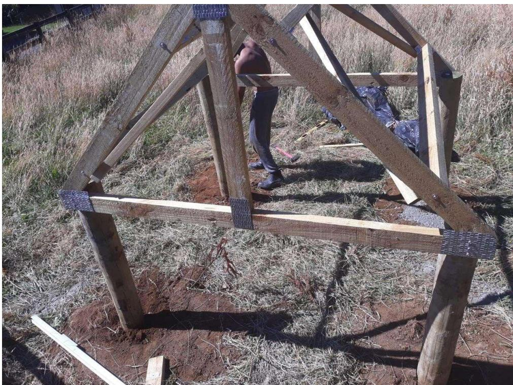
各支柱の位置でトラス骨組みをボルト留めするか、長いテックススクリューを数本使用して固定します。昼下がりの影で、トラスフレームが東西の向きに取り付けられていることが確認できます。
