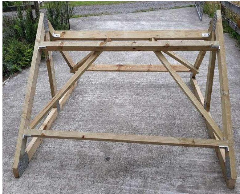
横方向の補強には、4本の50x 50 x1200mmのフェンスあて木を使用していることにご注目ください。一般的なテックネジ、ギャングネイルプレート、angled bracketで固定されています。
