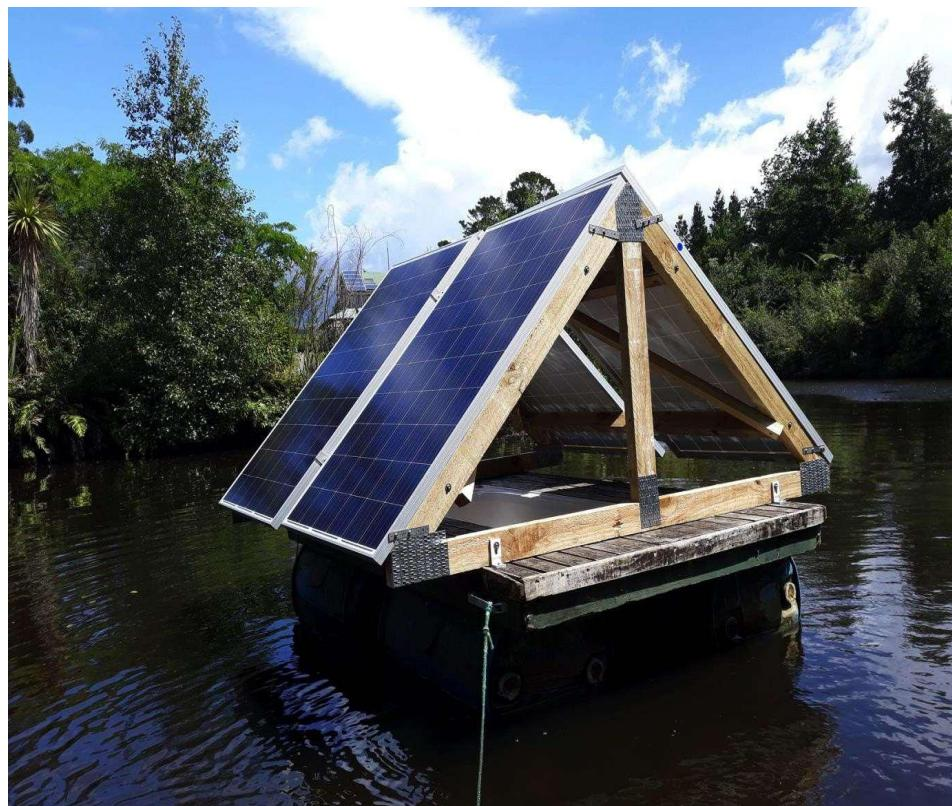
ご覧の通り、プラスチックドラムの水没率は40%以下で、正常に機能していることがわかります。次に、トラス構造の三角形フレームを浮舟にスライドさせ、アングルブラケットで取り付けました。この場合、パネルはステンレス製のビルダーストラップで木造フレームに取り付けました。
