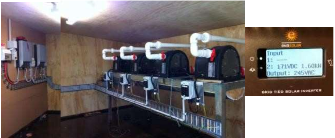
6.4kW: 4 x PLT200(DC171Vで動作) EnaSolarパワーコンディショナ2x4kWシステム
