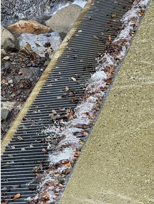
日本でのマイクロ水力発電での取水方式には、古来、場所ごとに多種多様な方式がとられてきました。溪流での取水スクリーンは古くから【チロリアン方式】と呼ばれる方式を用い、水の流れに平行に設置されたバースクリーン方式による、バー間隙間から水を落下させます。(一例を左記写真で示します)
