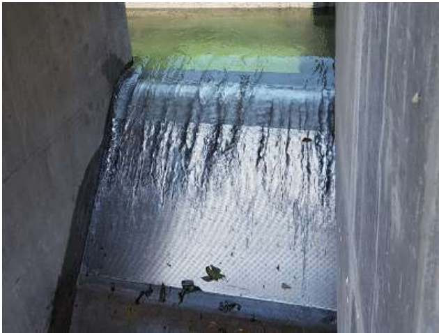
【取水量 320ℓ/秒、幅 1.9m、傾斜距離 1.1m】
