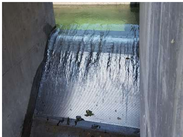
【取水量 320ℓ/秒、幅 1.9m、傾斜距離 1.1m】
