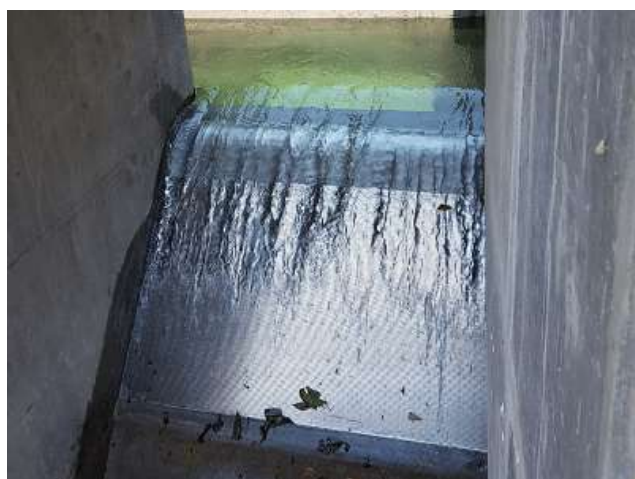
【取水量 320ℓ/秒、幅 1.9m、傾斜距離 1.1m】
