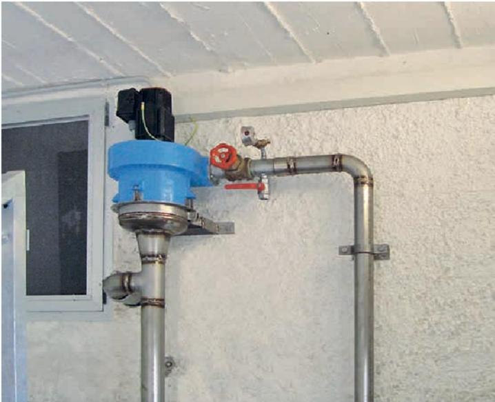
このタイプの水力発電所は、電力が非常に少なく、送電網がない場合に使用されます。蓄電池充電専用です。IREM は、非常に低い電力とサイズのタービンを供給でき、高品質で信頼性の高い製品でこれらのニーズを満たします。典型的な適用場所は、シンプルなシステム、設置の容易さ、メンテナンスの少なさが求められる 避難所、コテージ、山の牧草地などです。
