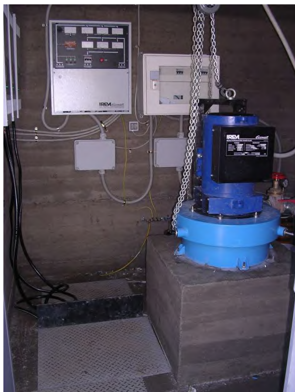
ペルトンタービン 左側最上段は操作盤
