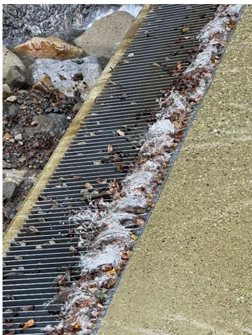
日本でのマイクロ水力発電での取水方式には、古来、場所ごとで多種多様な方式がとられてきました。渓流での取水スクリーンは古くから【チロリアン方式】と呼ばれる方式を用い、水の流れに平行に設置されたバースクリーン方式による、バー間隙間から水を落下させます。(一例を左記写真で示します)
