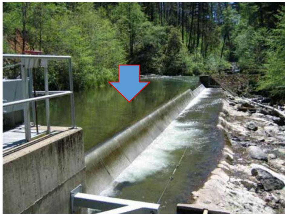
この池で比重1以上が池に沈み、比重1以下は流れ、コアンダスクリーンで除塵効果が得られます。スクリーン間隔は1mm(通常)で製作されています。
