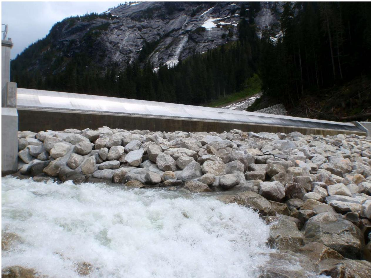
横幅総長 61メートル、取水量 26.5 トン/秒、年間発電量 273,000 MWh です。急流箇所の設置理由から、ウェッジワイヤーは標準品より更に堅牢な、HD(ヘビーデューティー)を採用しています。
